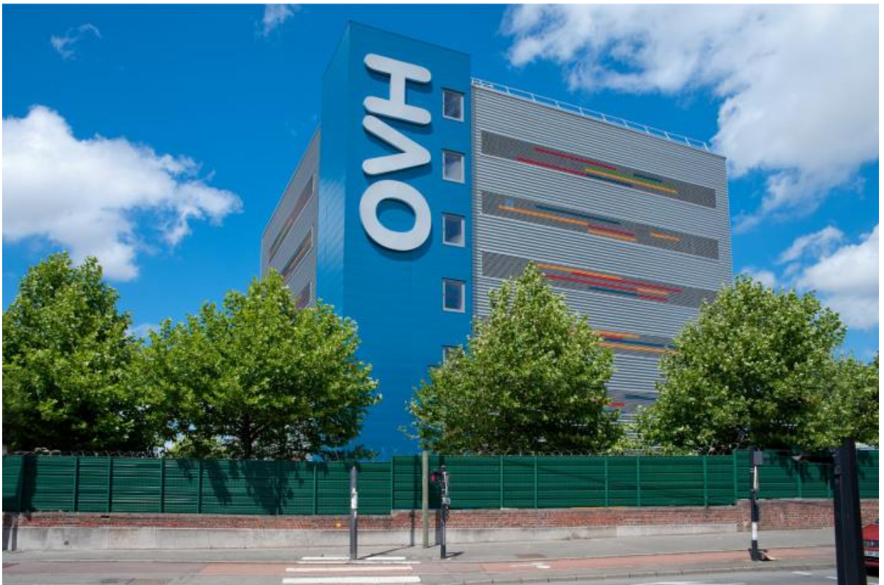
Imagen 1. Datacenter Roubaix (Francia)
